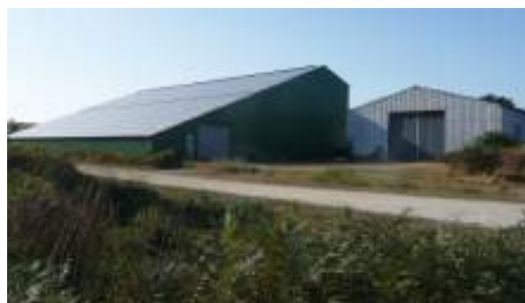
Bâtiments agricoles au Nord du site de projet
