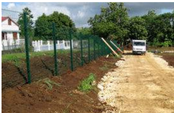
Pose d'une clôture en acier galvanisé et mailles soudées (source : Neoen)
