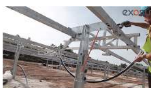
Montage arceaux (ex. de photos d'Exosun)
