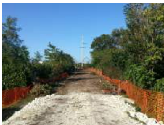
Clôture de chantier (crédits photos : erea-conseil)
