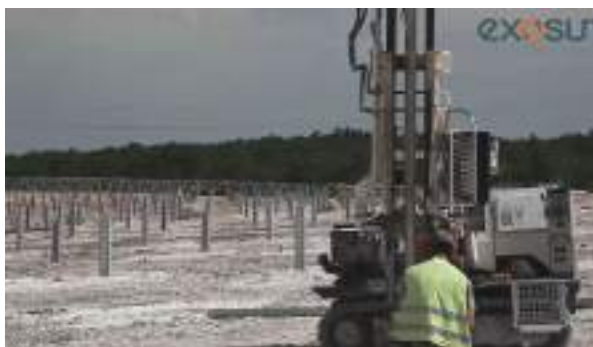
Montage des fondations (exemple de photos d'Exosun)
