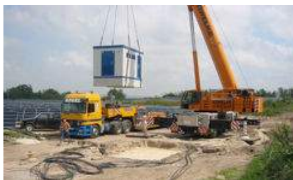
Pose des postes onduleurs (source : Neoen)
